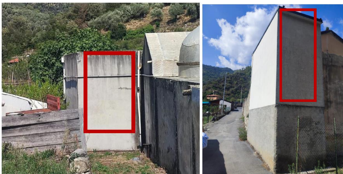
Figura 16: ipotesi di sito d'installazione presso il cimitero comunale di Torri.
