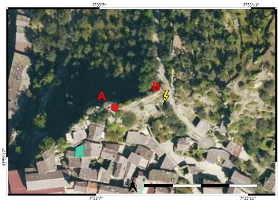
Figura 3 – Localizzazione del sito di installazione in Saorge.
