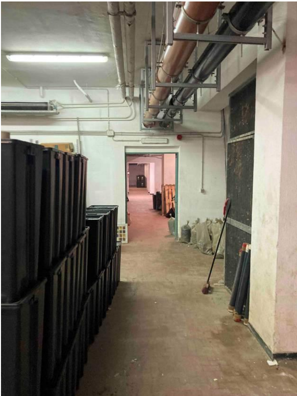
locale deposito piano sotfondi
