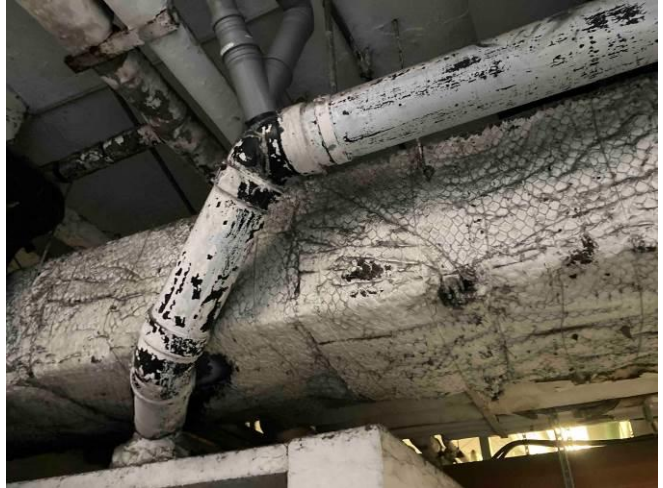
particolare rivestimento canali
