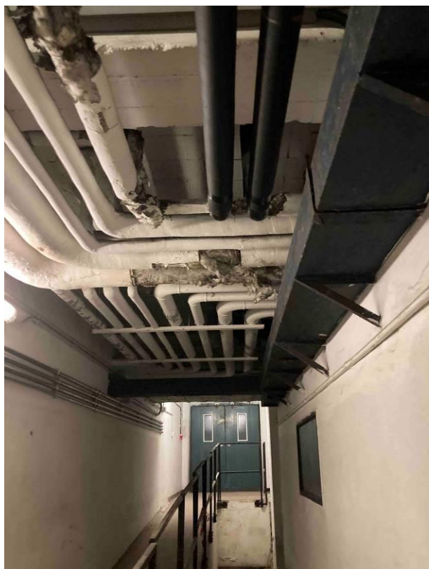
Corridoio distributivo piano sottofondi
