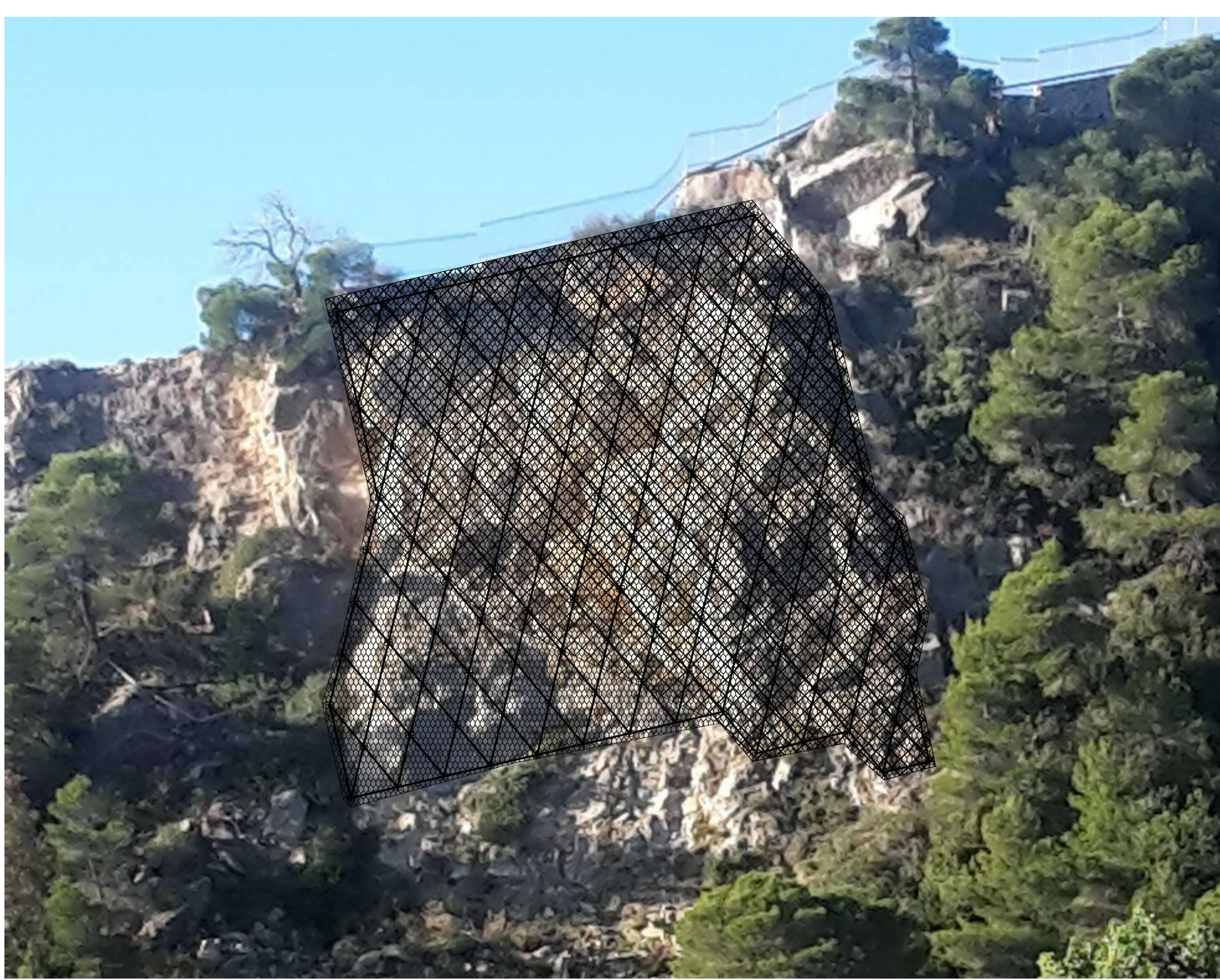
VISTA FRONTALE DEL FRONTE ROCCIOSO DA CONSOLIDARE
