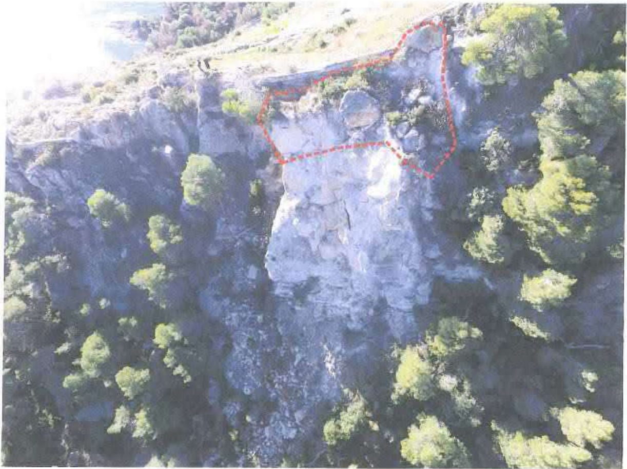
Foto 3: zona soggetta a disaggio con esplosivo e martinetti idraulici
