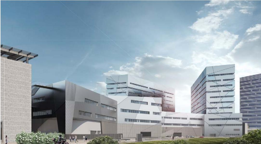
Il parcheggio privato posto al livello P-1 costituisce, insieme al parcheggio pubblico al P-2, il basamento dell'intero complesso. Architettonicamente è caratterizzato da un rivestimento esterno permeabile in lamiera stirata con un'altezza di circa 7.00 m.
